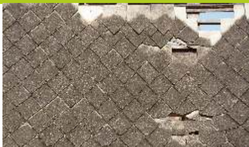
repedezett beázó palatető
