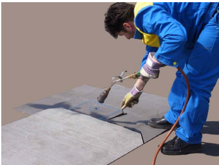
2. ábra Az első filces lemezsáv felhegesztése
