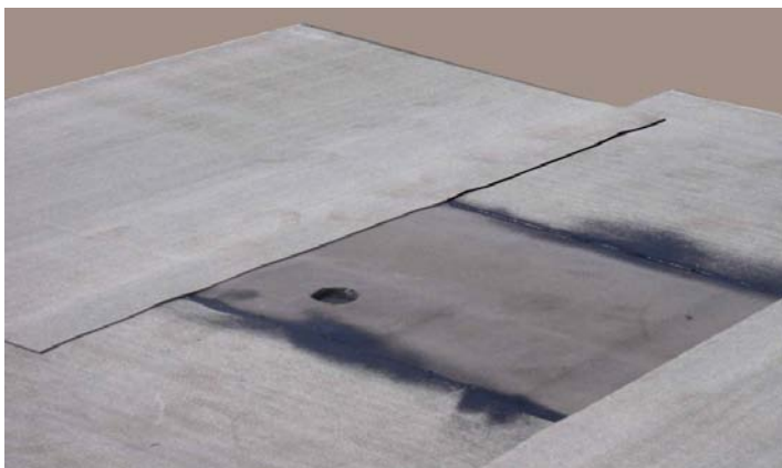
3. ábra A filces lemezsávok csatlakozása az összefolyónál
