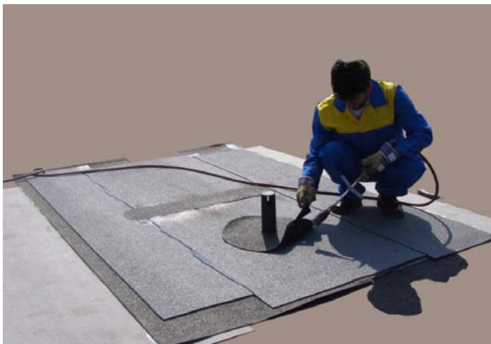
5. ábra A zárógallér lehegesztése
