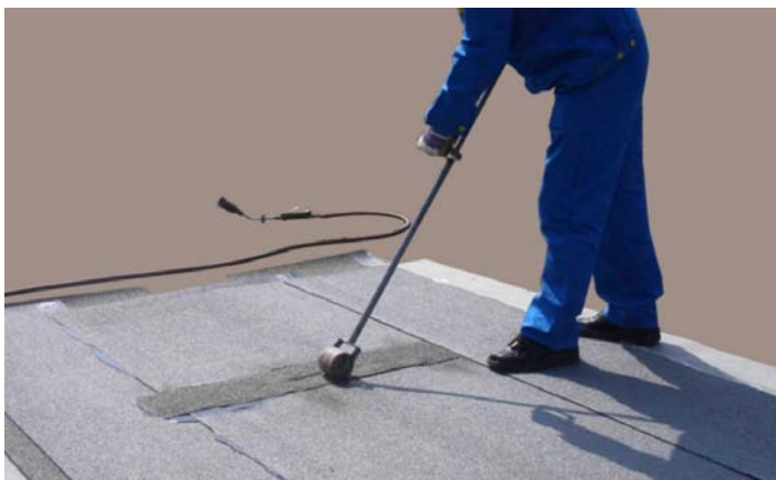
3. ábra A toldósáv áthengerezése
