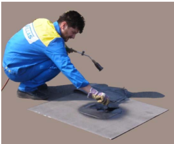
1. ábra Az összefolyó felületét olvasztott bitumennel kenjük be
