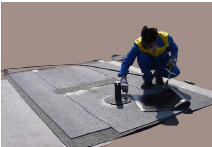
3. ábra A szellőzőtalp bekenése olvasztott bitumennel
