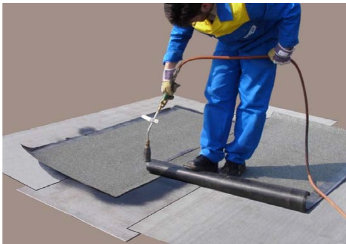
5. ábra Zárólemezszávok felhegesztése
