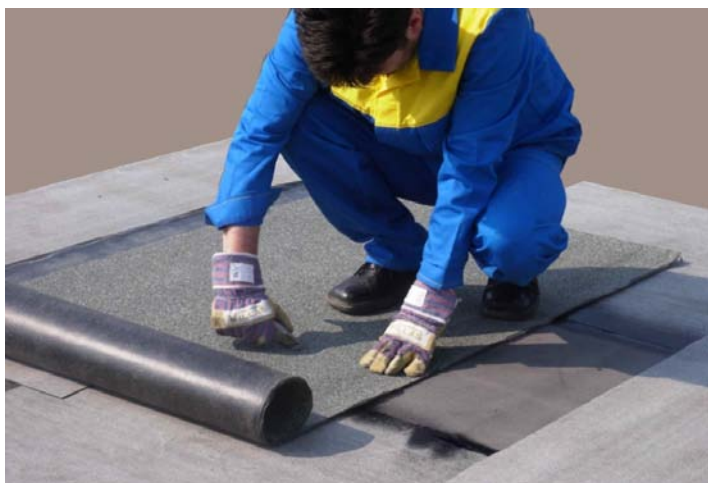
4. ábra Az első zárólemezszáv illesztése
