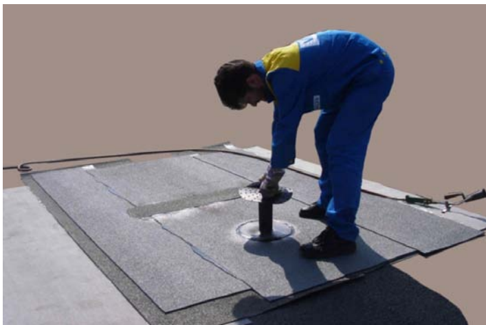
2. ábra A szellőzőlyuk bejelölése kivágás előtt
