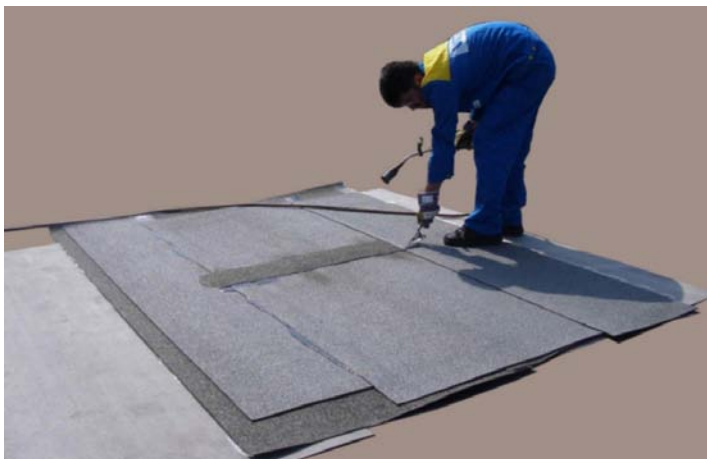
2. ábra A toldósáv az átfedősáv alá fut be
