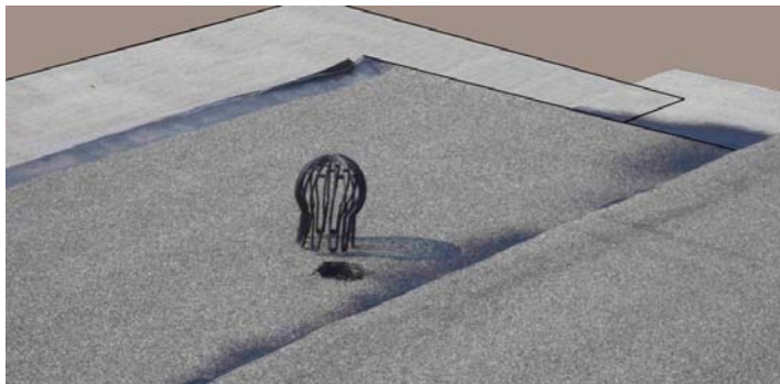
6. ábra Beépített összefolyó a lombkosárral
