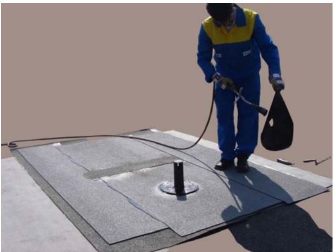
4. ábra A zárógallér közepének meglágyítása
