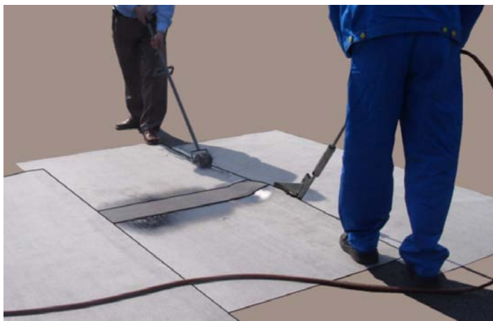
4. ábra Átfedősáv összehegesztése szélezőégővel
