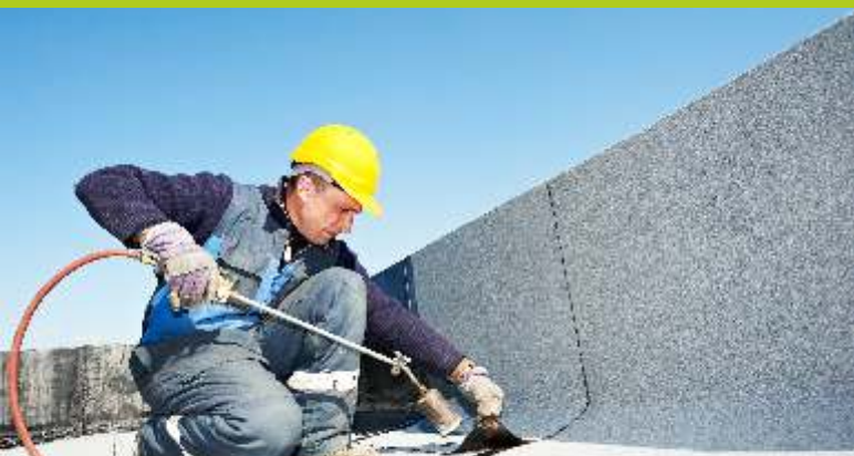
Lapostető szigetelés prémium bitumenes lemezzel
