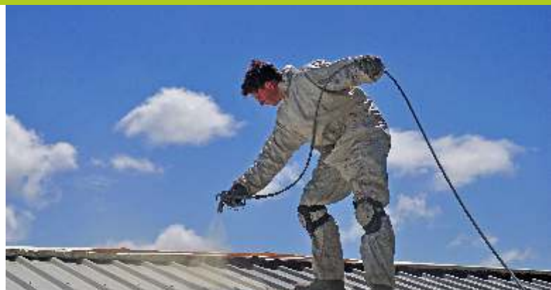
Tetőszigetelés magas és lapostetőn poliuretánnal
