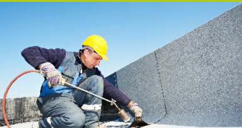
Lapostető szigetelés prémium bitumenes lemezzel
