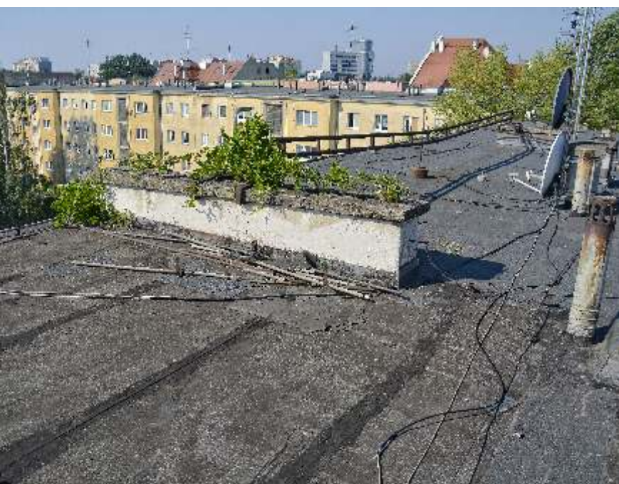
foltozott, beázó lapostető
