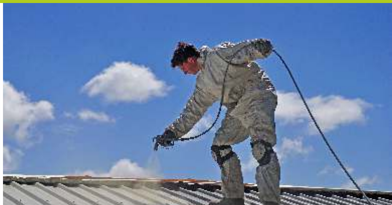
Tetőszigetelés magas és lapostetőkön poliuretánnal
