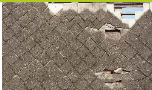
repedezett beázó palatető
